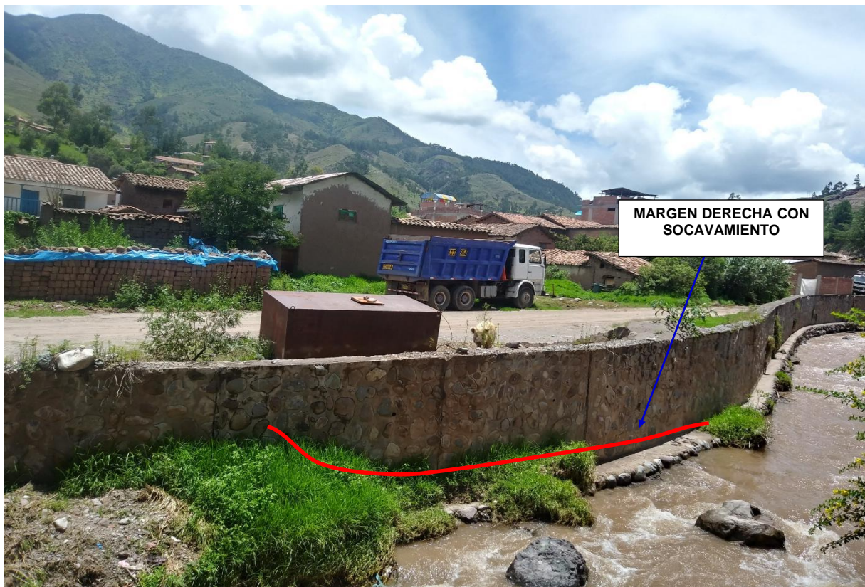
FIGURA N° 02: RIO PARURO EXPUESTO ANTE SOCAVAMIENTO AL MURO DE PROTECCION EN LA POBLACION.
