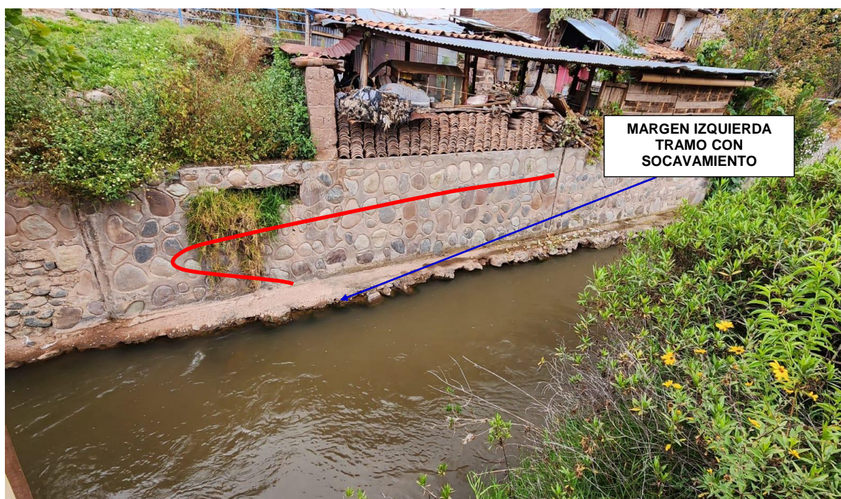
FIGURA N° 03: EN LA BASE DE MURO DE PROTECCION MARGEN DERECHA EXISTE SOCAVAMIENTO EN LA EPOCA DE LAS MAXIMAS AVENIDAS, Y CONSTRUCCION EN FAJA MARGINAL POR LA POBLACION DE PARURO.
